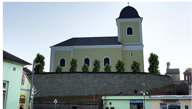
Kostel po opravě.
