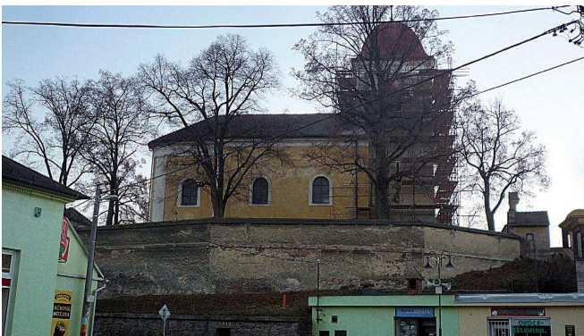
Kostel před opravou.
